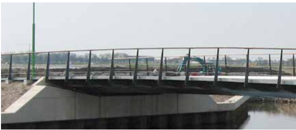
Fietsbrug bij brugvariant
